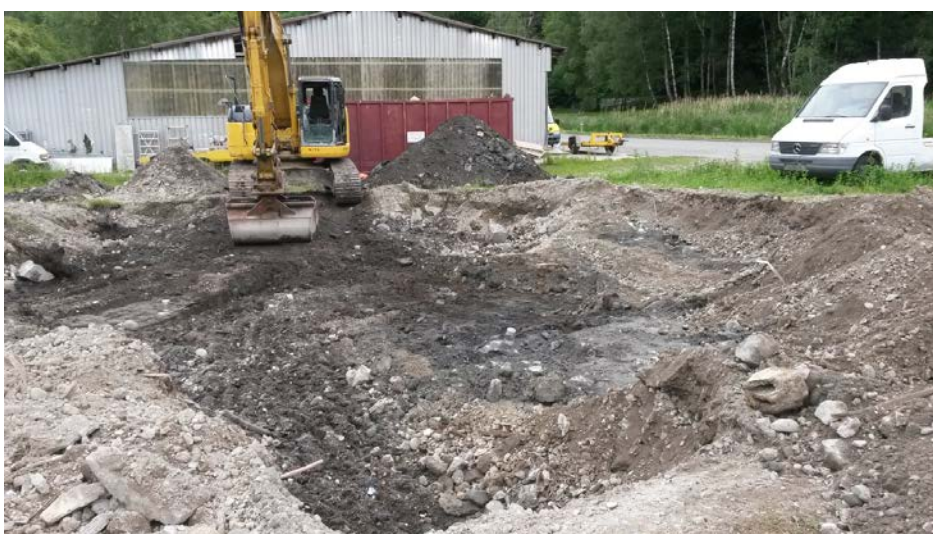
Tri des matériaux pollués, du remblai et de la tourbe
