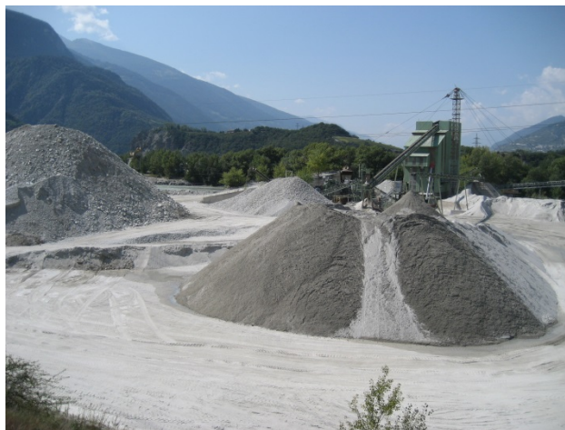
Vue de la gestion des matériaux
