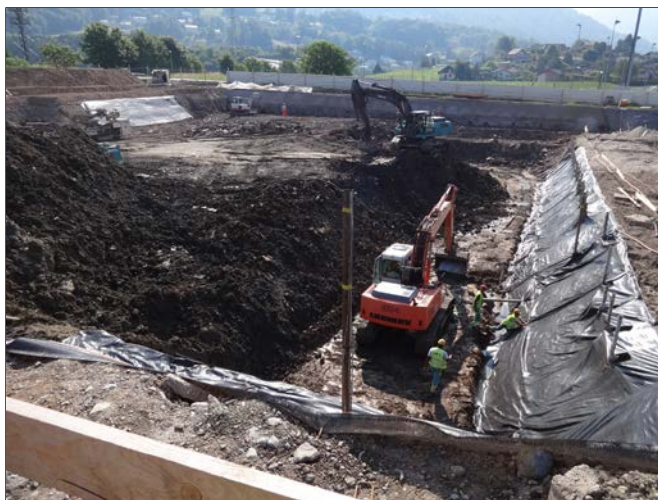
Vue du site pendant les travaux d'excavation
