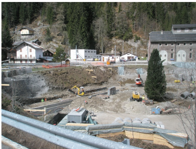
Vue du chantier : préparation d'un emplacement
