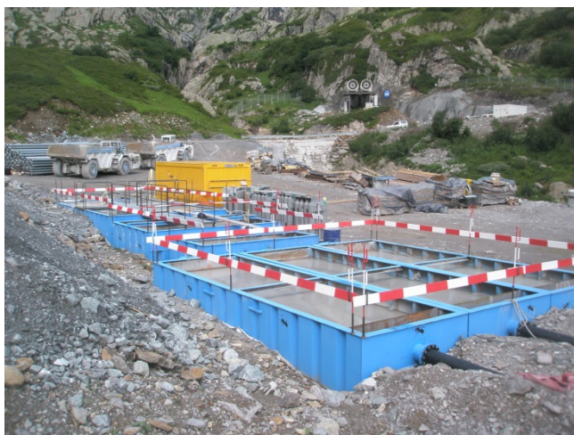
Vue de l'installation de traitement des eaux (activité de chantier)
