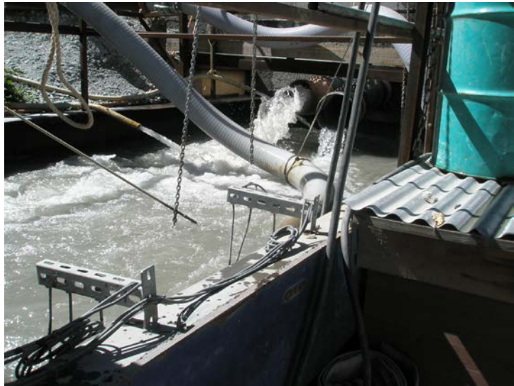
Traitement des eaux de chantier
