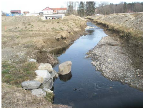
Déviation provisoire d'un ruisseau
