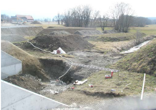
Construction d'un pont et gestion des eaux de chantier et de la terre végétale
