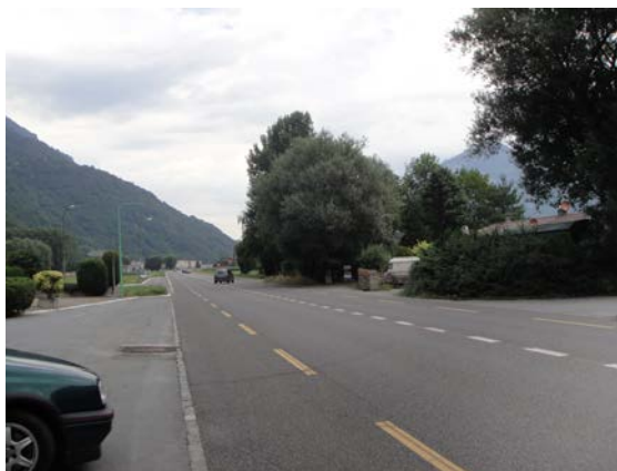
Deux voies avec deux pistes cyclables
