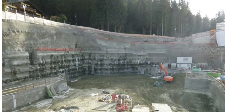
Travaux spéciaux du secteur A
