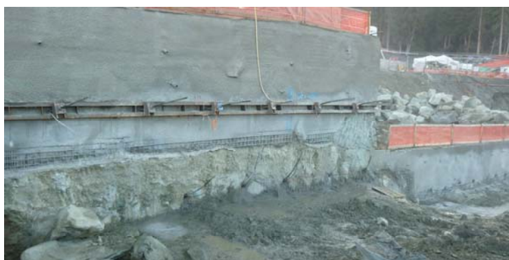
Paroi jetting ancrée
