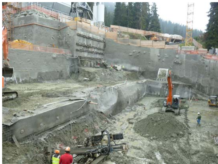
Travaux spéciaux au sud des secteurs B et C
