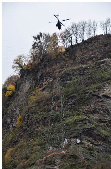
Montage d'un pylône en milieu de paroi (Salvan)
