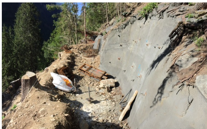
Patte de pylône en cours d'exécution
