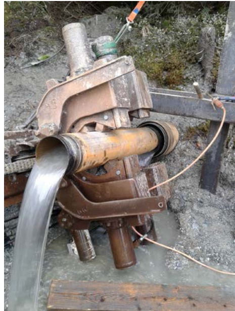
Forage d'exploitation F4 pour remplacer la galerie de captage de la Barmasse, à Lourtier (commune de Bagnes)
