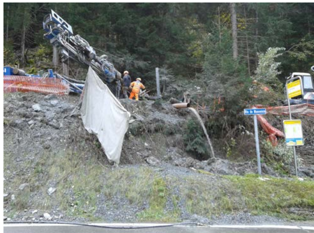
Forage d'exploitation F4 avec un débit de 300 à 1800 l/mn (commune de Bagnes)
