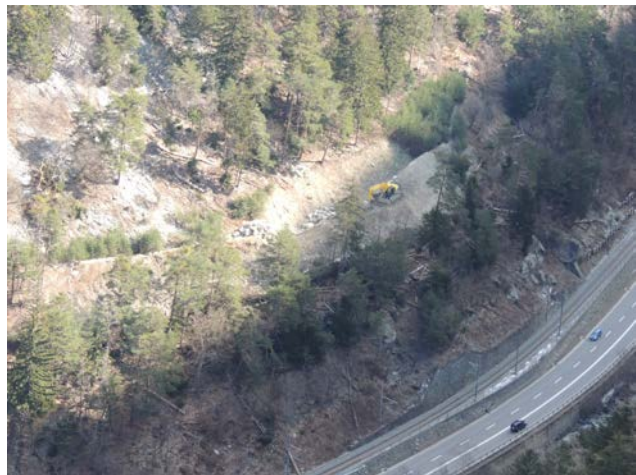
Réfection de la digue après la chute de bloc du 29.01.2016, au lieu-dit "la Fory"
