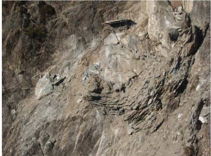
Câblage des blocs instables au lieu-dit "La Fory", au-dessus de la route internationale du Gd-St-Bernard
