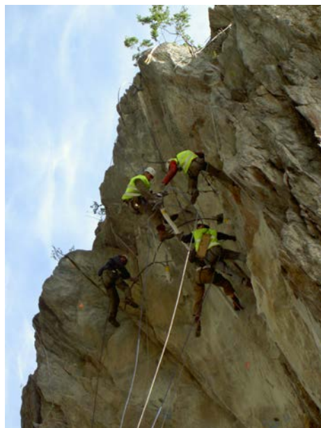
Pose d'ancrages passifs préinjectés dans la niche d'arrachement au-dessus de la galerie de la Monnaie
