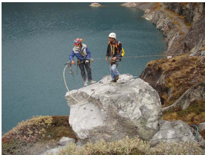
Minage d'un bloc instable au-dessus du barrage du Vieux-Emosson
