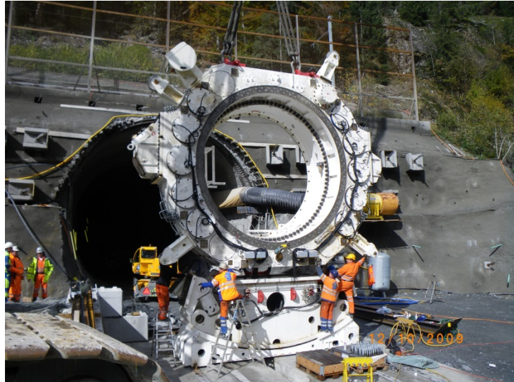
Vue de la tête du tunnelier en cours de montage
