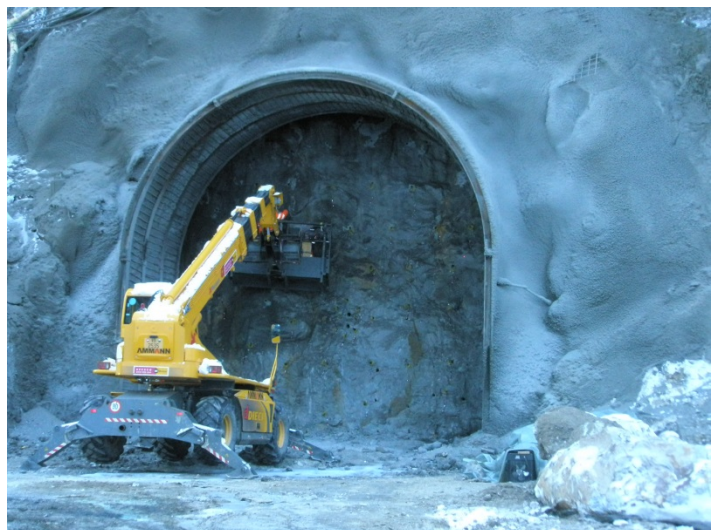
Initialisation d'un tunnel excavé à l'explosif
