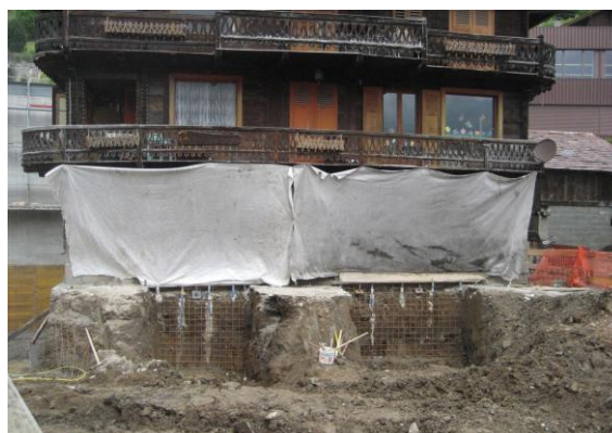
Injections de sols, terrassement par étapes
