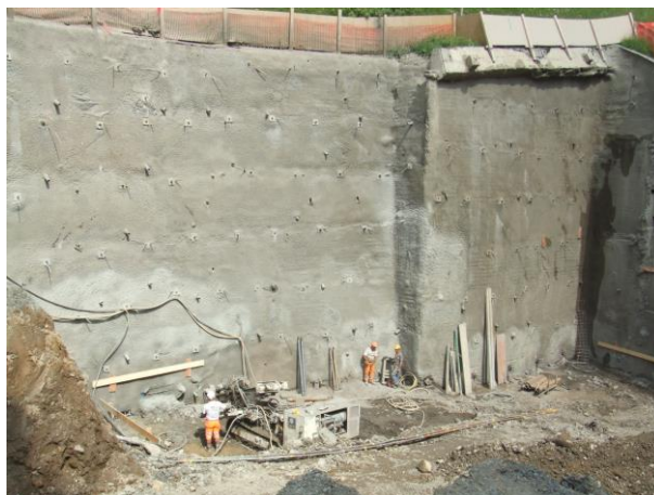
Paroi gunitée et clouée
