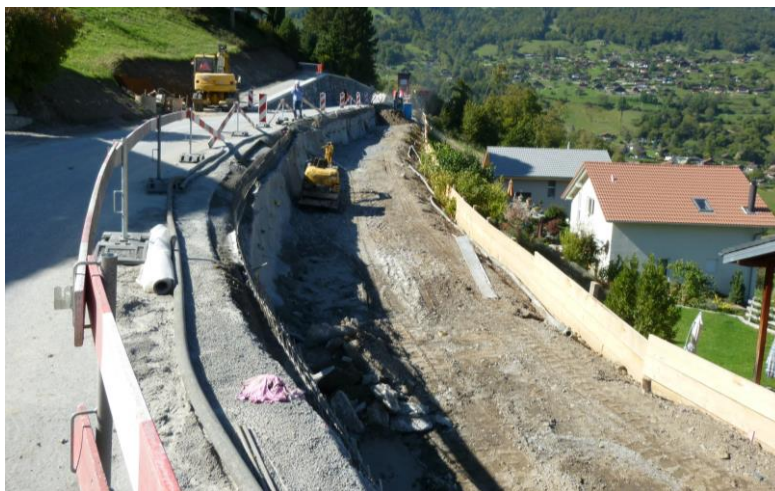
Terrassement et travaux spéciaux à l'aval du site
