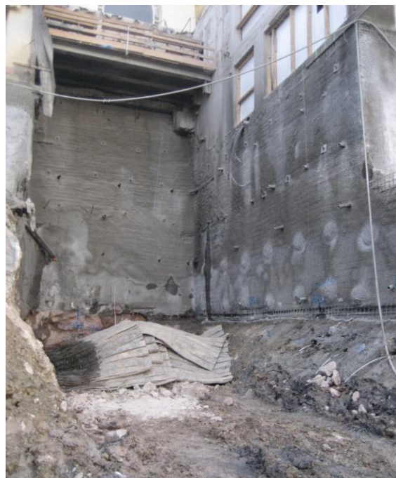
Injections clouées et gunitées dans le puits central
