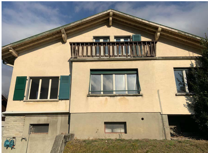
Vue de la Villa diagnostiquée
